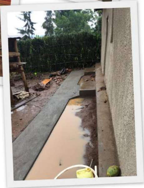
Vorgarten mit neuer Rasenfläche, neuen Wegen und neuem Regenablaufsystem
